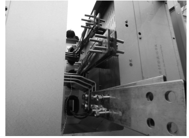
图4 开关柜内母排实物图
